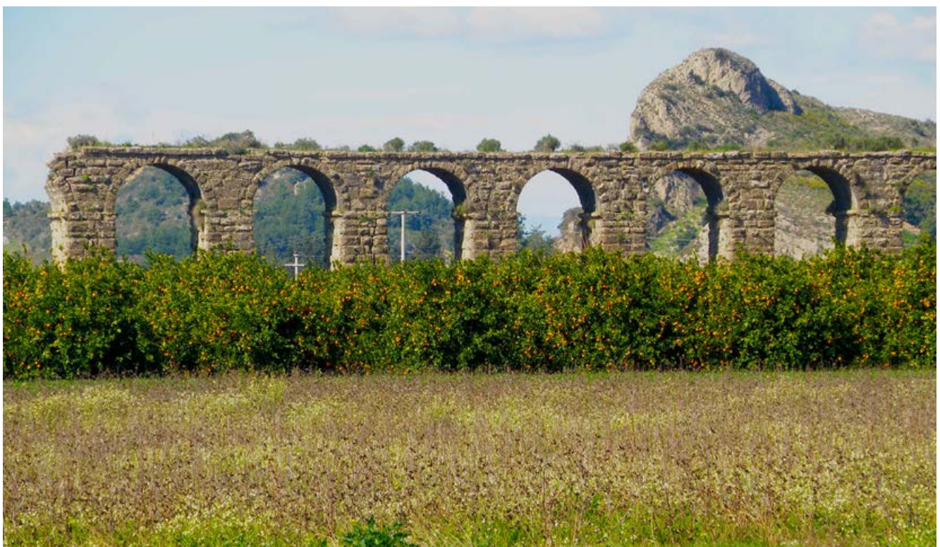
Abb. 27: Aspendos, Bögen der Druckwasserleitung (JN)
