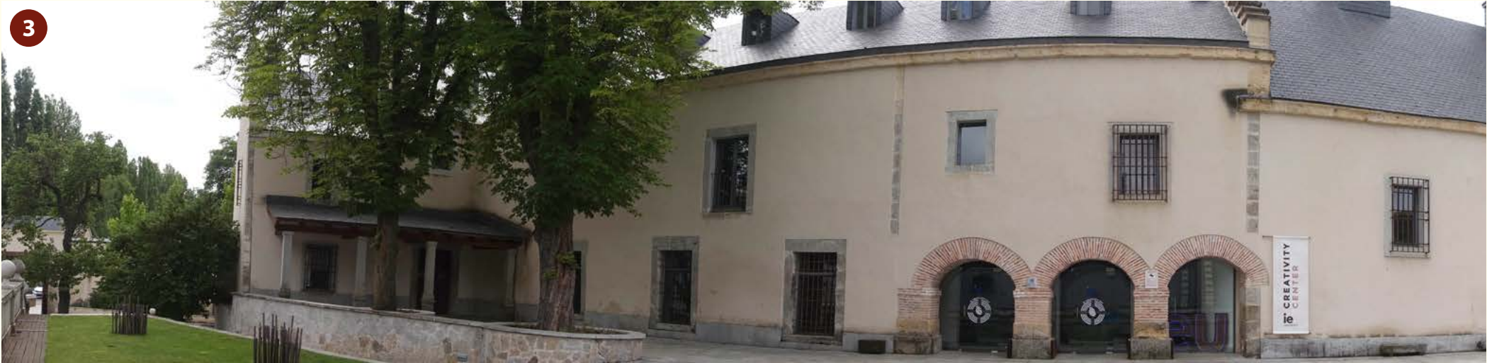
Der große L-förmige Gebäudekomplex, in dem das angelieferte Metall weiterverarbeitet wurde. Foto: UK.
