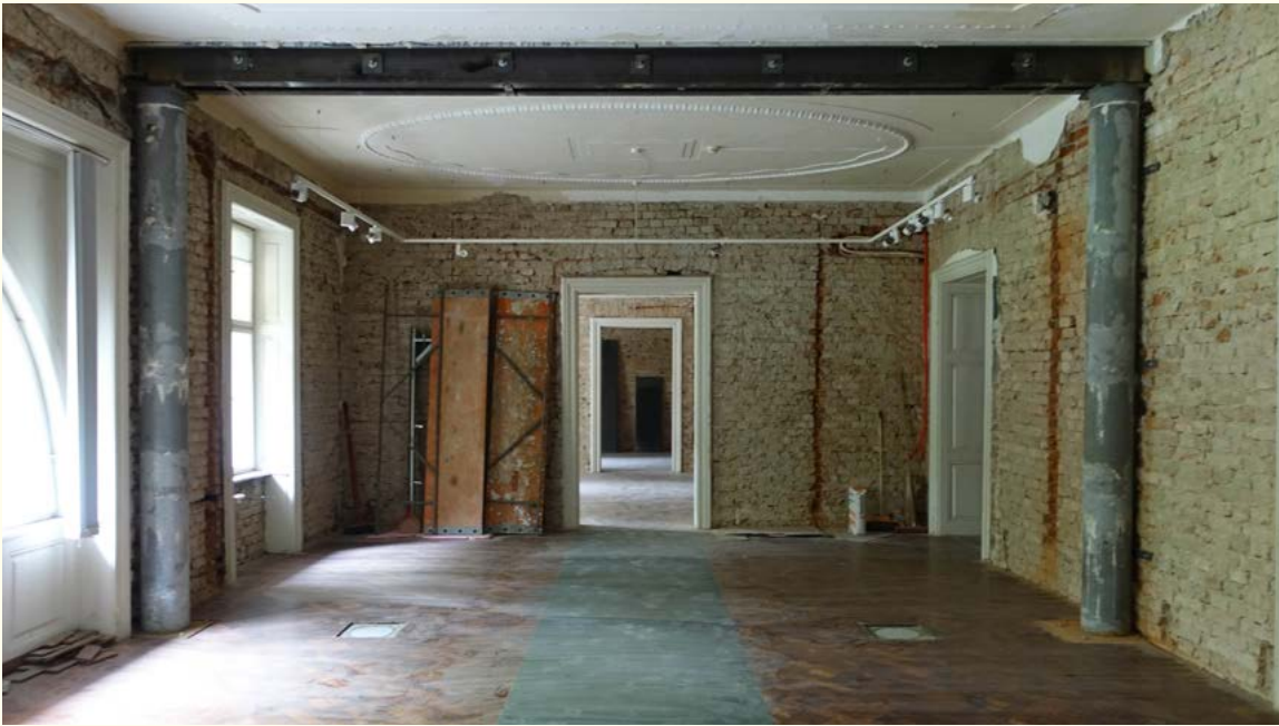
Schon bei meinem Besuch im Juli 2020 waren erste Zeichen zu sehen, dass die Wiederaufbauarbeiten bald beginnen sollten. Foto: UK.
