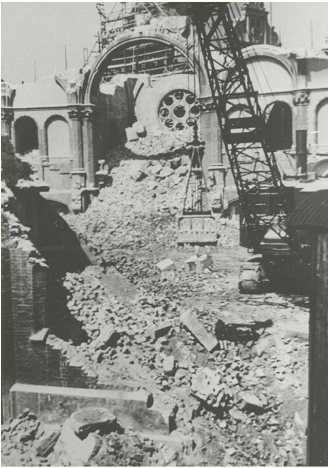
Der Abbruch der alten Hauptsynagoge im Juni 1938. Leo Baeck Institut AR 3680
